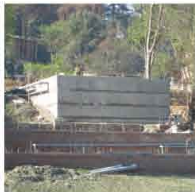
完成した分散型排水処理施設 ▶
